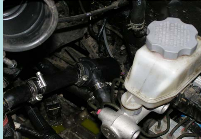
Установка жидкостного насоса
