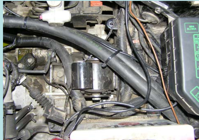
Прокладка жидкостных шлангов
