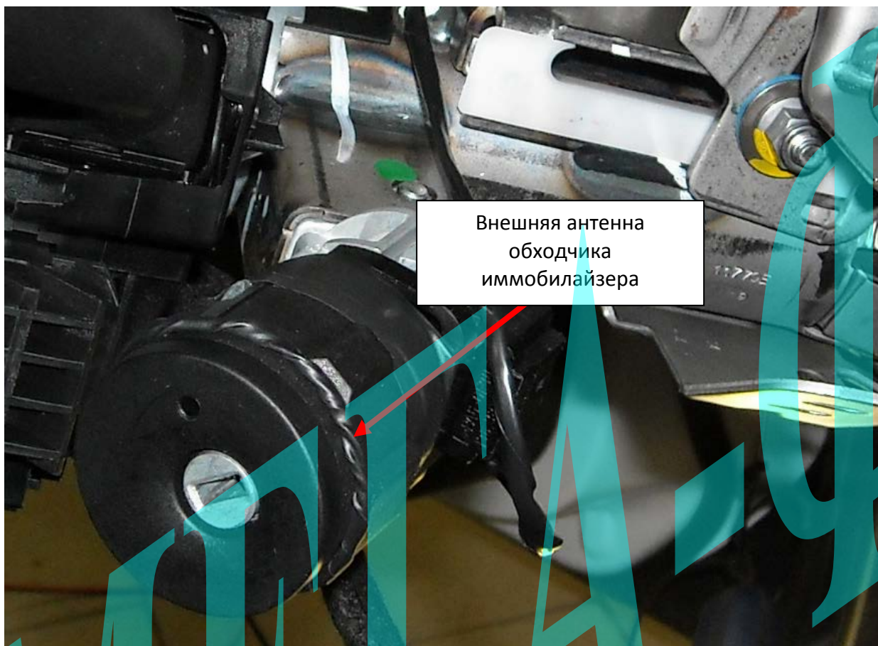
Рис. 6: Установка внешней антенны обходчика.
