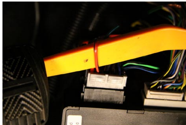
Фото 13.2. Силовой провод дверей (красно-черный)
