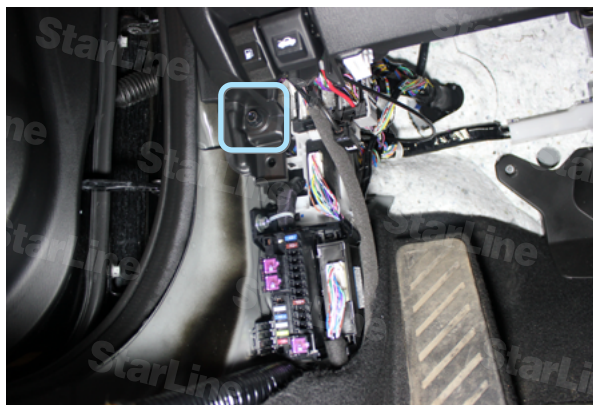
Фото 1.4. Накладка левой кик-панели снята, болт крепления подторпедника
