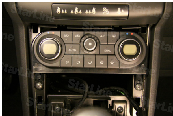
Фото 2.1. Демонтаж облицовки климат-контроля
