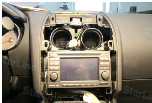
Фото 2.2. Демонтаж облицовки магнитолы
