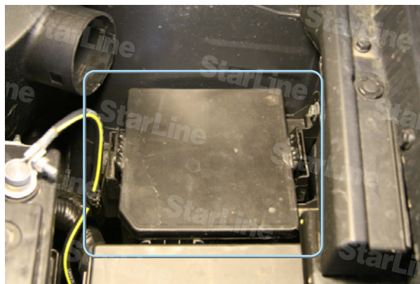
Фото 20.1. Блок реле и предохранителей
