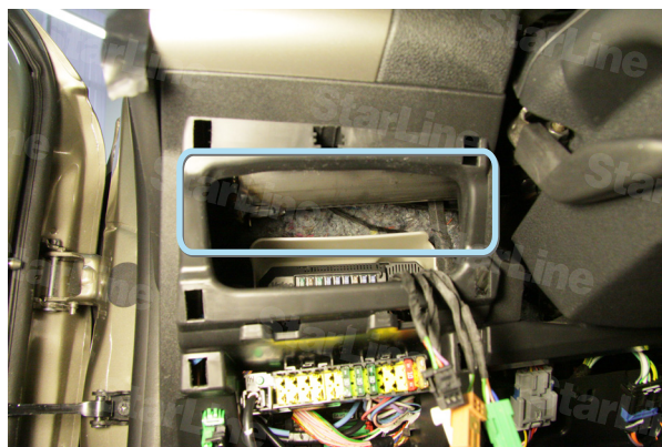
Фото 6. Место установки блока сигнализации
