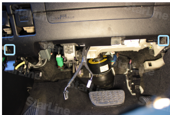
Фото 1.4. Нижняя накладка снята; болты
