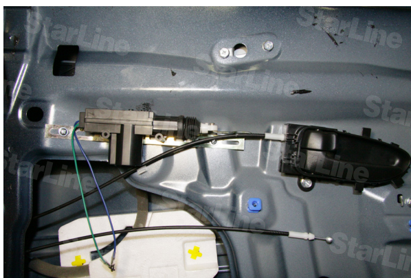
Фото 12.5. Внешний вид установленного электропривода двери водителя
