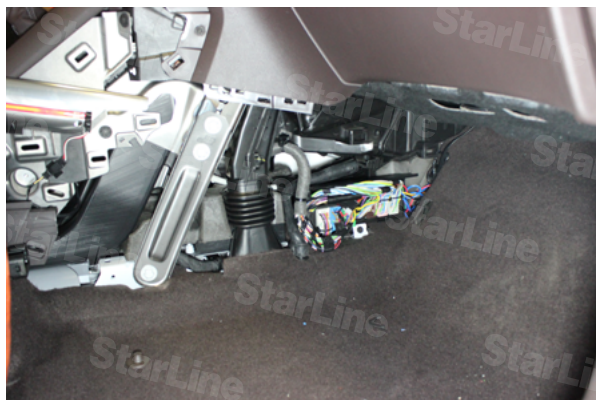
Фото 1.4. Правая накладка центрального тоннеля снята
