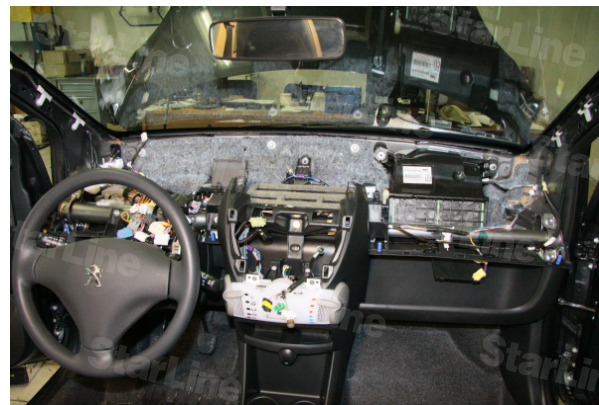
Фото 3.8. Верхняя накладка «торпедо» снята
