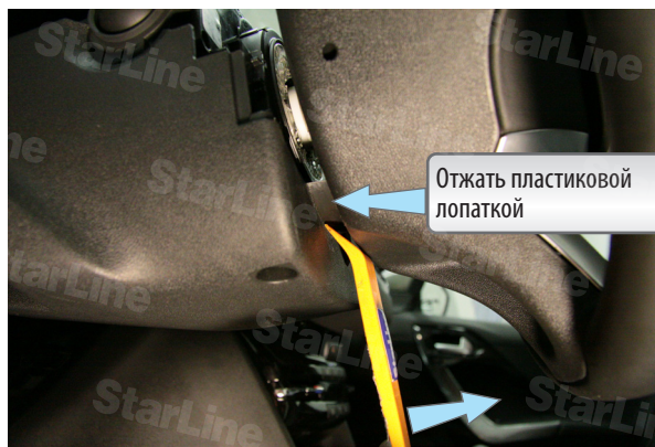
Фото 2.2. Снятие нижней части рулевого кожуха
