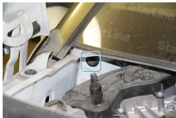
Фото 4.2. Накладка снята, нужный уплотнитель
