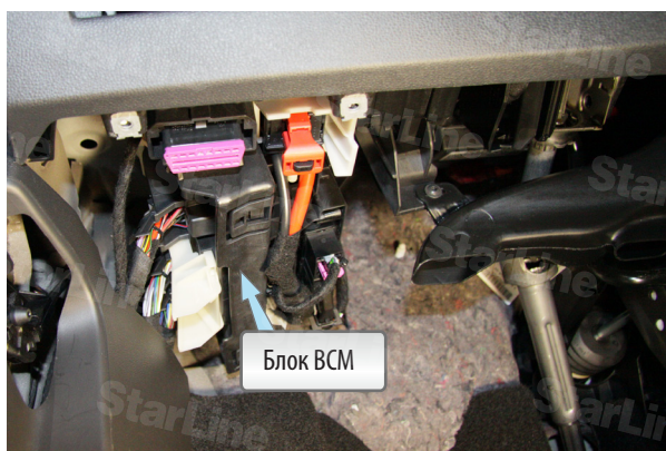
Фото 10.1. Месторасположение блока BCM
